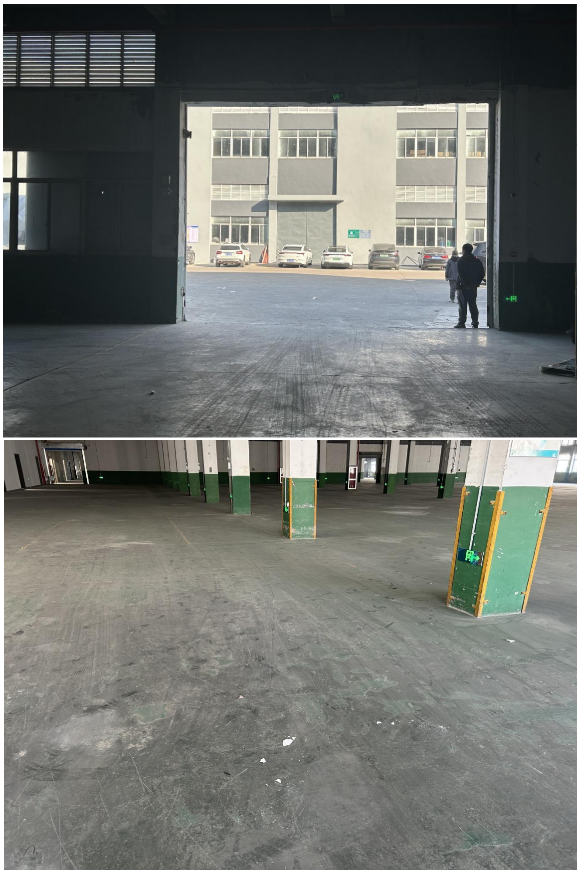
图 4-5 本项目厂房地面
