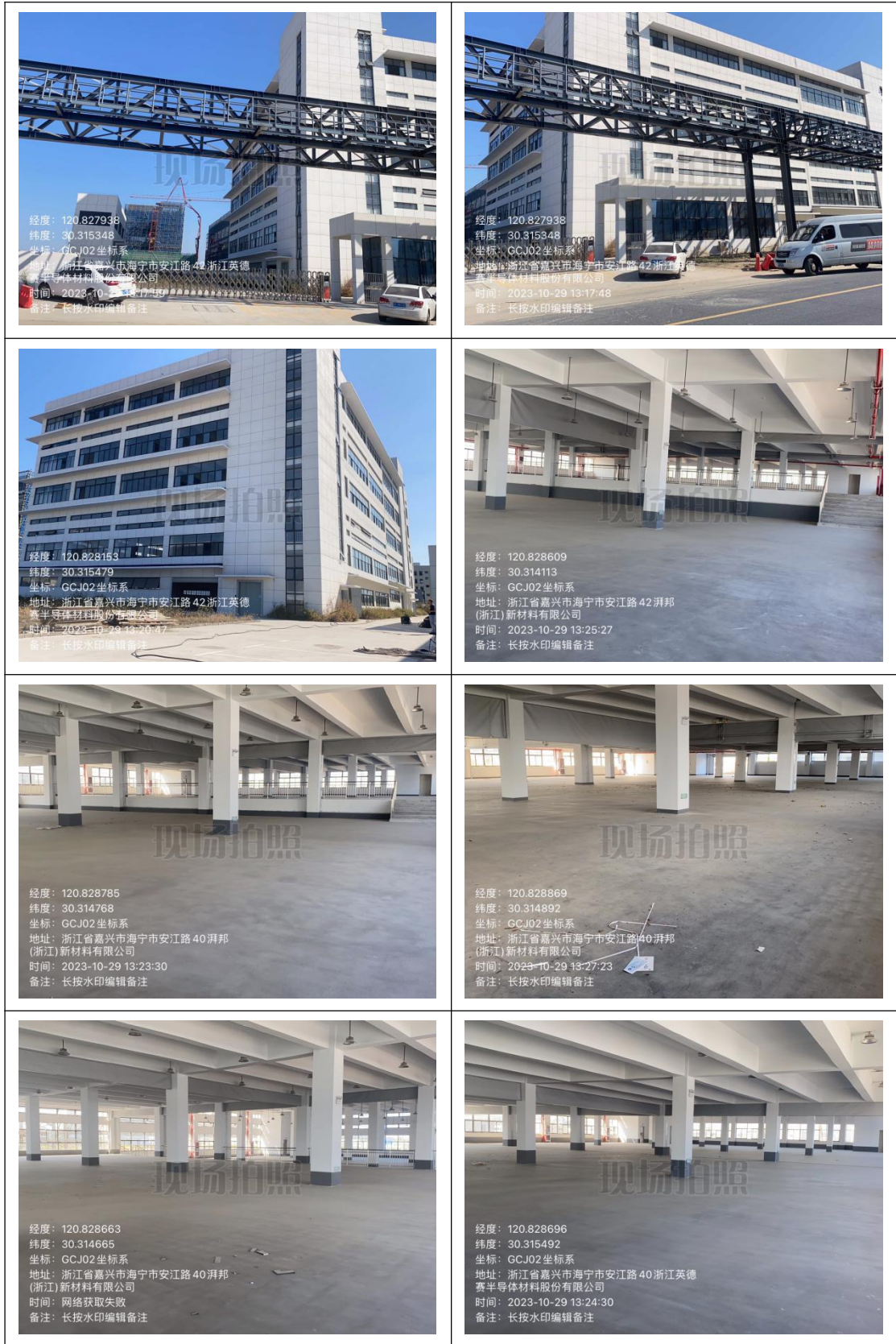
附件 10 整改后的项目现场照片
