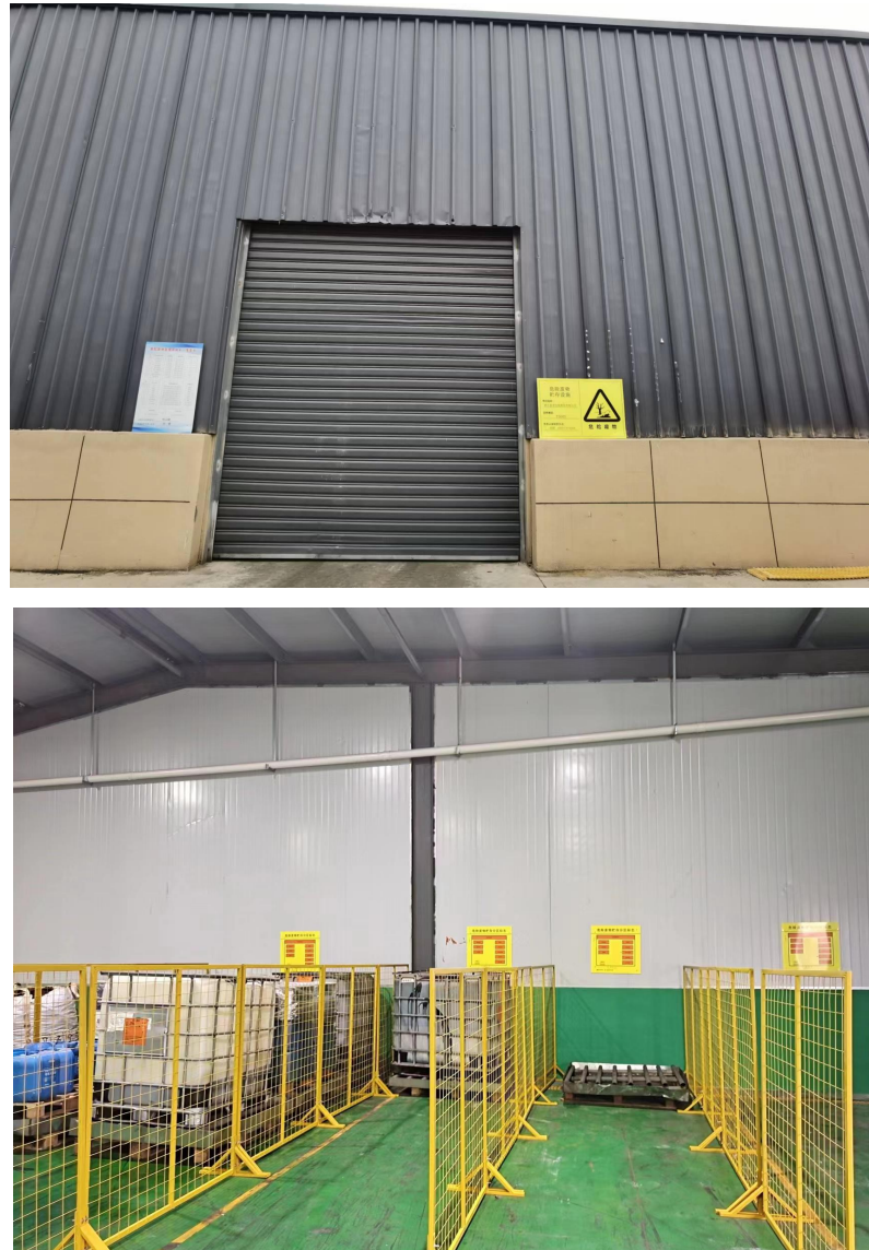
图 2-11 现有项目天通路厂区危废仓库
