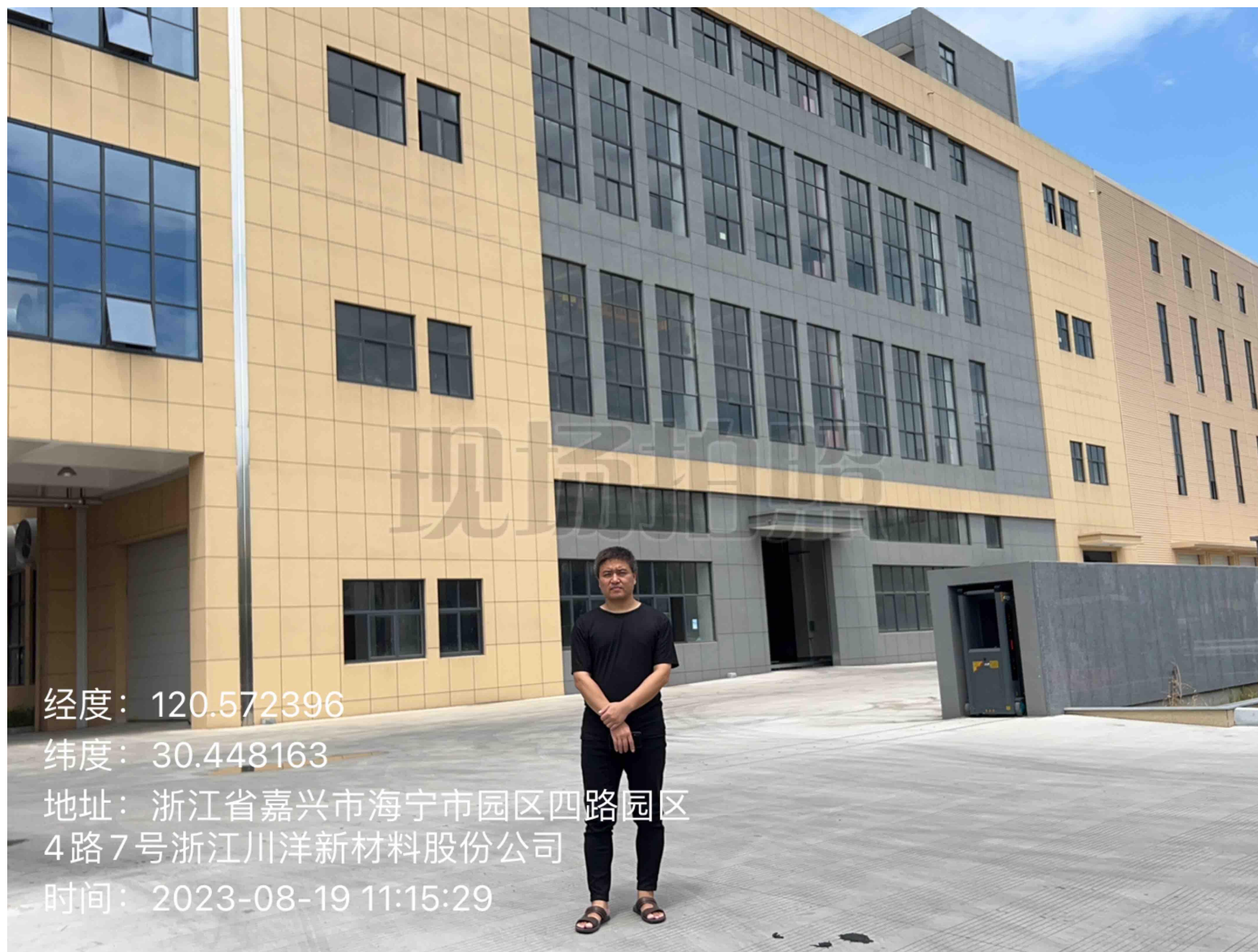
附图6 现场踏勘照片（园区四路厂区）
