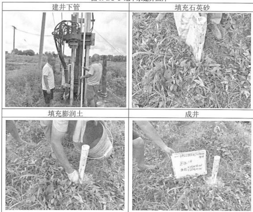
图 1.4.2-1 地下水建井照片
