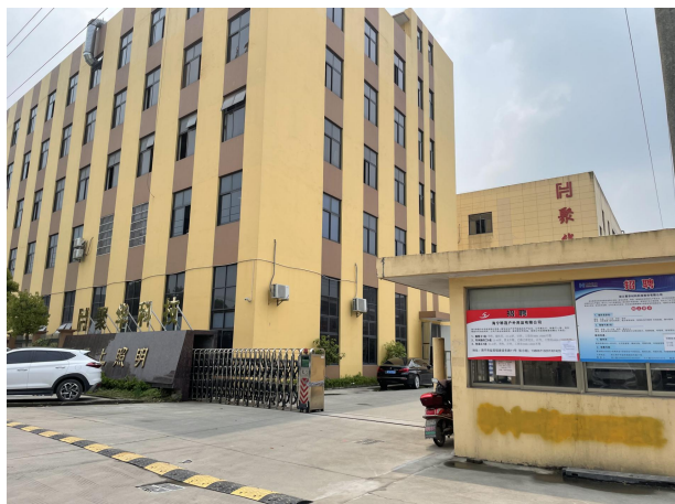
东侧（海宁景上照片科技有限公司）
